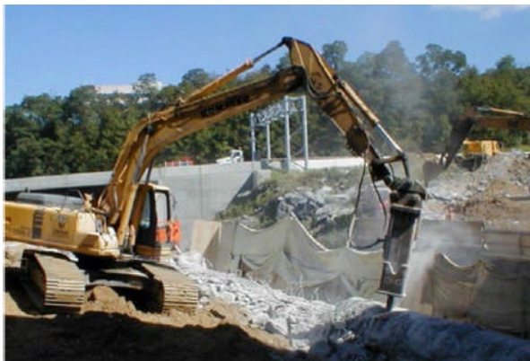
Excavadora equipada con cabina cerrada y brazo de grúa demoliendo un muro de hormigón.
