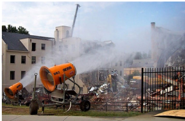
Los cañones de atomización, como la unidad DustBoss de la imagen, son una forma eficaz de eliminar el polvo de sílice.
