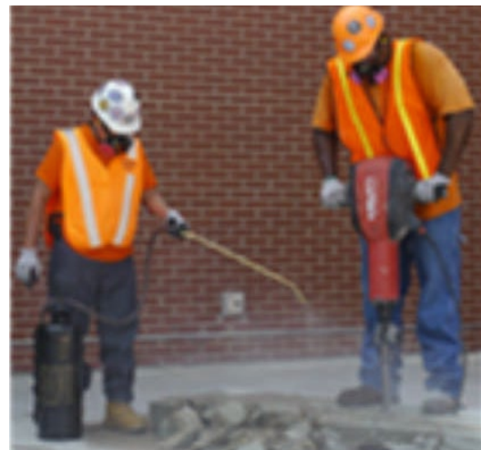
Un empleado aplica agua utilizando un aspersor portátil para reducir el polvo mientras el otro martilla.
