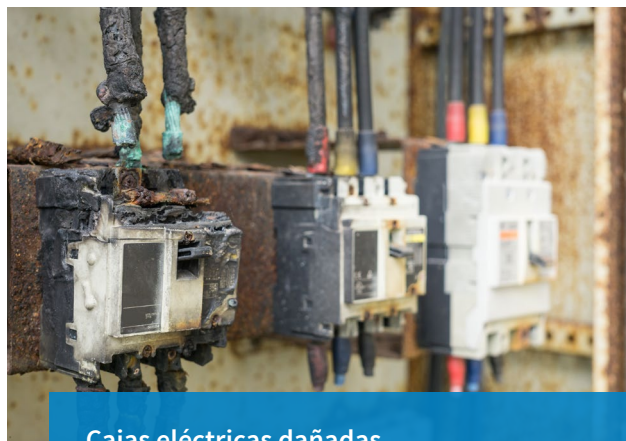
Cajas eléctricas dañadas.
