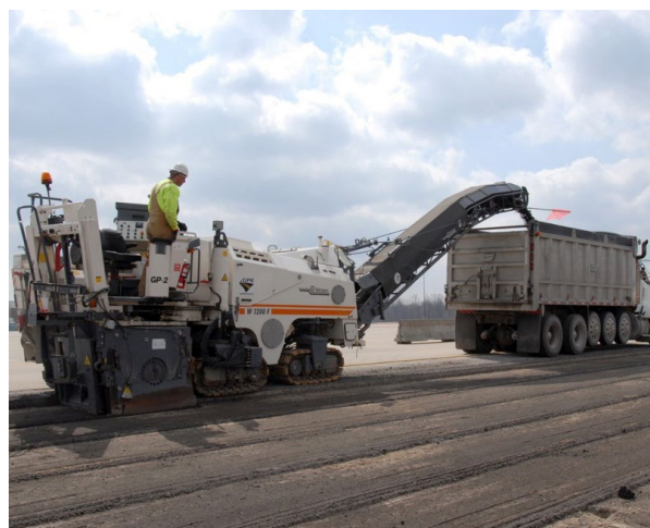
Máy cắt vát đang cắt vát đường nhựa và thu gom các mảnh vụn lên xe tải.
