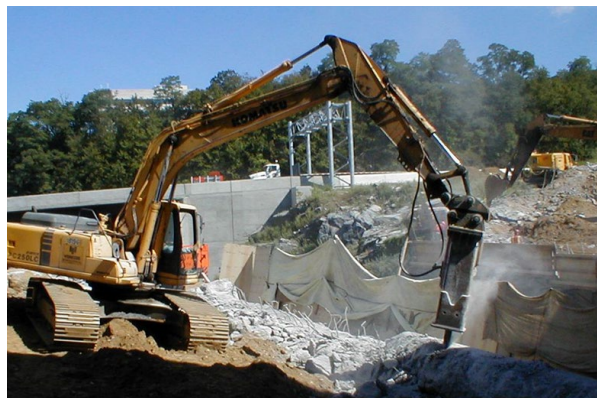
Máy xúc được trang bị cabin kín và cuốc để phá tường bê tông. Hình ảnh của CPWR.
