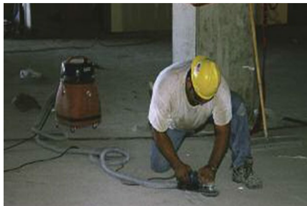
Công nhân mài sàn bê tông bằng máy mài có gắn bộ thu bụi (ở nền sau).
