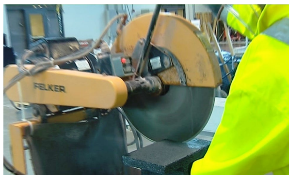
Công nhân cắt khối xây bằng máy cửa khối xây cố định được trang bị hệ thống cấp nước tích hợp liên tục cấp nước cho lưới cửa. Lưu ý ống cấp nước được gắn vào phần trên của tấm che quanh lưới cửa.
