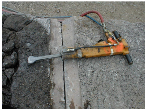
Martillo neumático equipado con un sistema de suministro de agua por aspersión para controlar el polvo. La boquilla de agua está montada en el marco del martillo neumático, justo a la derecha del cincel. Observe el hormigón húmedo a la izquierda por la aspersión de agua.
