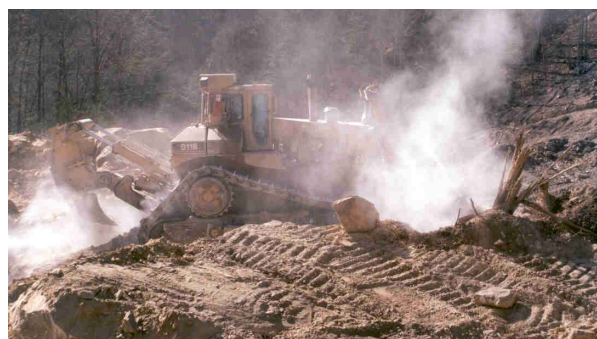
Movimiento de tierras utilizando un bulldozer equipado con cabina del operador cerrada. Foto cortesía de NIOSH.
