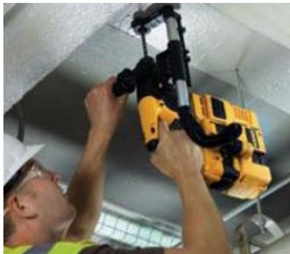
Trabajador taladrando hormigón con un martillo perforador equipado con un protector y un sistema de eliminación de polvo. Observe el protector alrededor de la broca, la manguera plateada y negra y el sistema de eliminación de polvo acoplados convenientemente al taladro.
