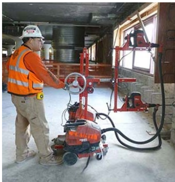
Un trabajador está taladrando agujeros horizontales en una pared de hormigón utilizando dos taladros montados en un soporte, cada uno equipado con un captador de polvo. Observe que los protectores alrededor de los taladros, la manguera negra y el colector de polvo están acoplados al soporte.
