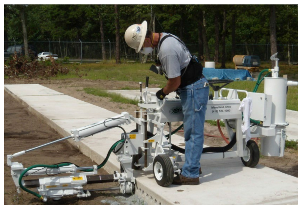
Trabajador taladrando agujeros horizontales en una losa de hormigón con un equipo de perforación con clavijas.
