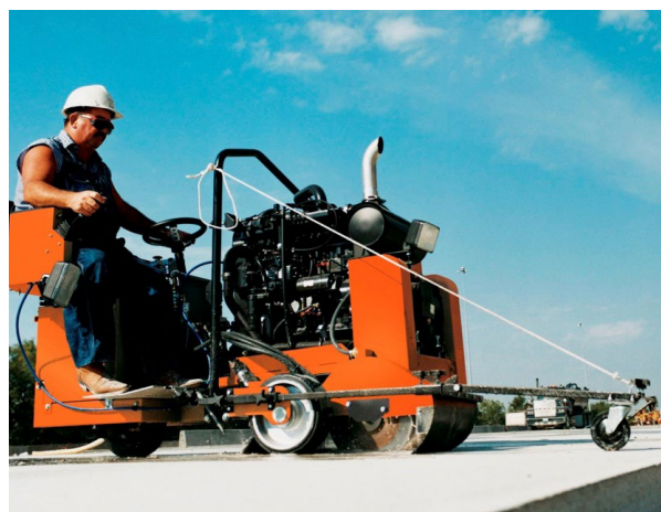
Trabajador cortando una ranura en una calzada de hormigón con una sierra conducible utilizando un sistema integrado de suministro de agua.
