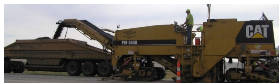
Fresadora de carretera fresando asfalto y cargando escombros en un camión de transporte.
