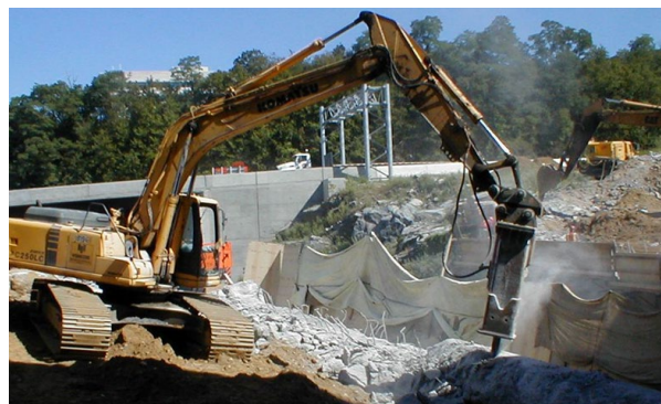
Excavadora equipada con cabina cerrada y grúa de elevación demoliendo un muro de hormigón.
