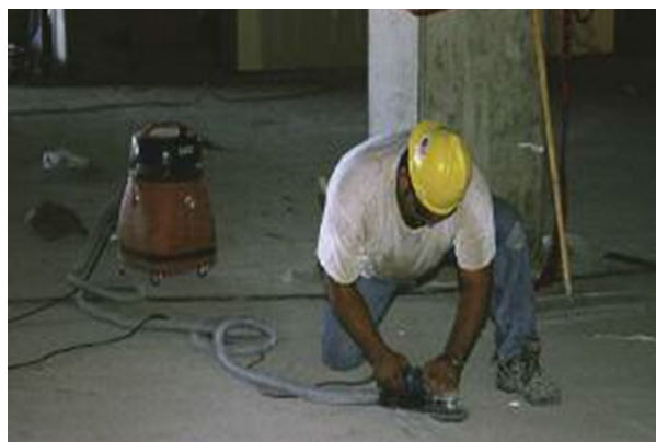
Trabajador esmerilando suelo de hormigón con una esmeriladora acoplada a un aspirador de polvo (fondo).
