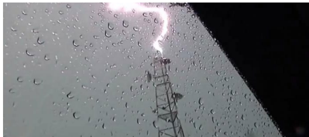
Figura 2: Un rayo cae sobre una torre de telecomunicaciones.
