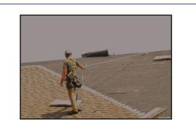
**Sujetador de cuerdas:** Asegúrese de tener un mecanismo de detención que evite que los trabajadores que usen sujetadores de cuerdas caigan por el borde del techo. Este mecanismo podría ser un accesorio o un simple nudo en la cuerda.
