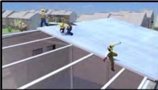
**Hecho fatal #3:** Cuatro trabajadores estaban recubriendo con láminas metálicas una plataforma de un edificio prefabricado. Uno de los trabajadores perdió el balance mientras caminaba por el techo y cayó a través de una abertura. Murió al día siguiente por las lesiones sufridas en la caída.
