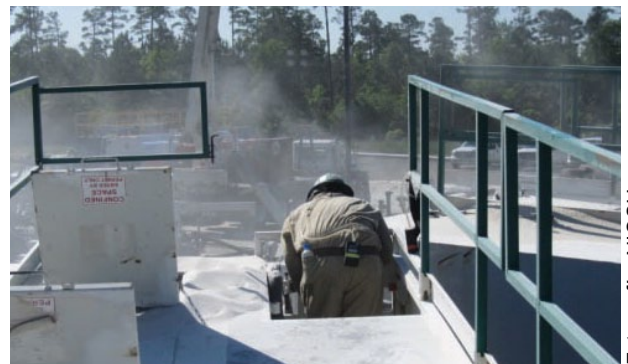
Nube de polvo de sílice junto a un trabajador que está pasando arena de una transportadora de arena a la correa de transferencia
