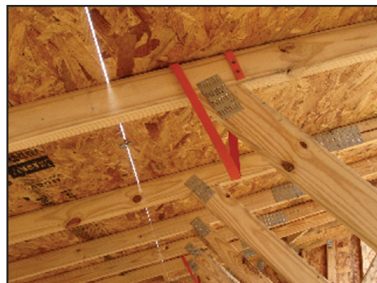
Sistema de anclaje instalado de antemano en un ático.
